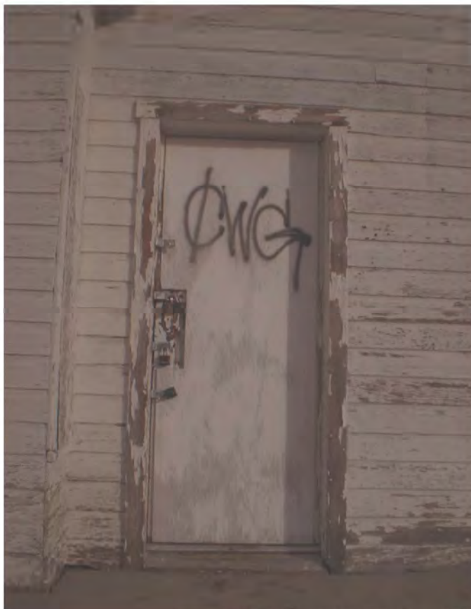
Door 4 exterior side
