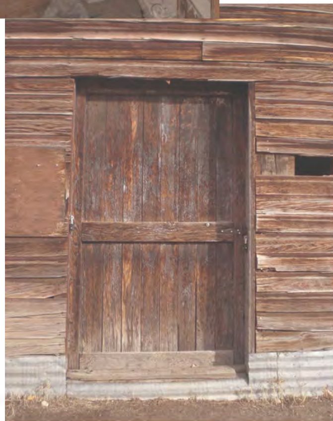
Door 6 exterior side
