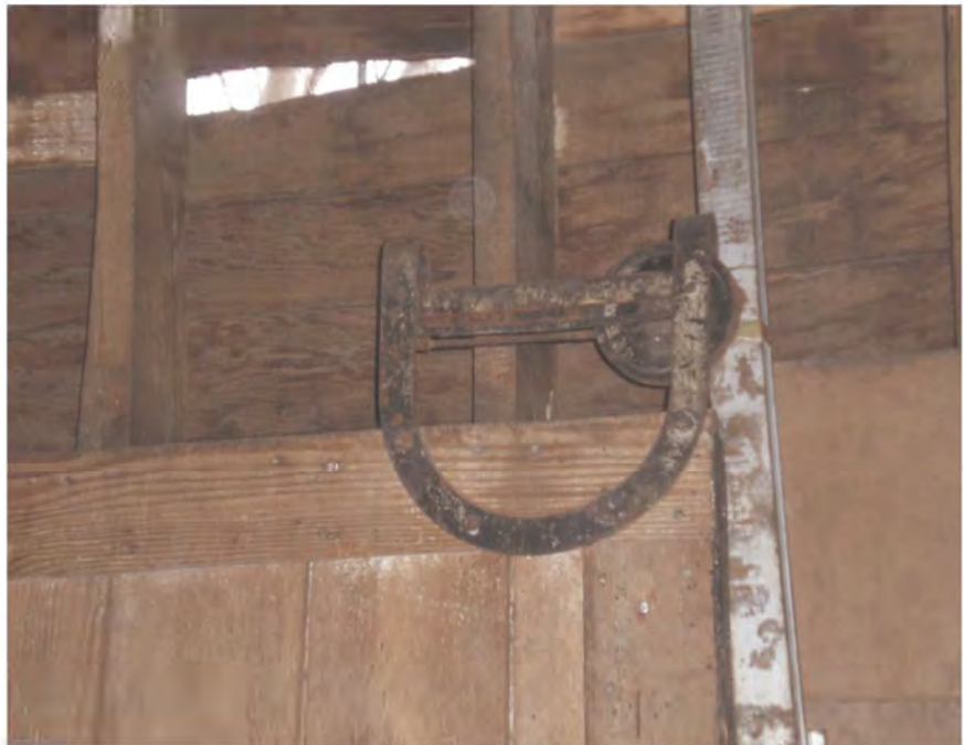
Door 7 original sliding door hardware
